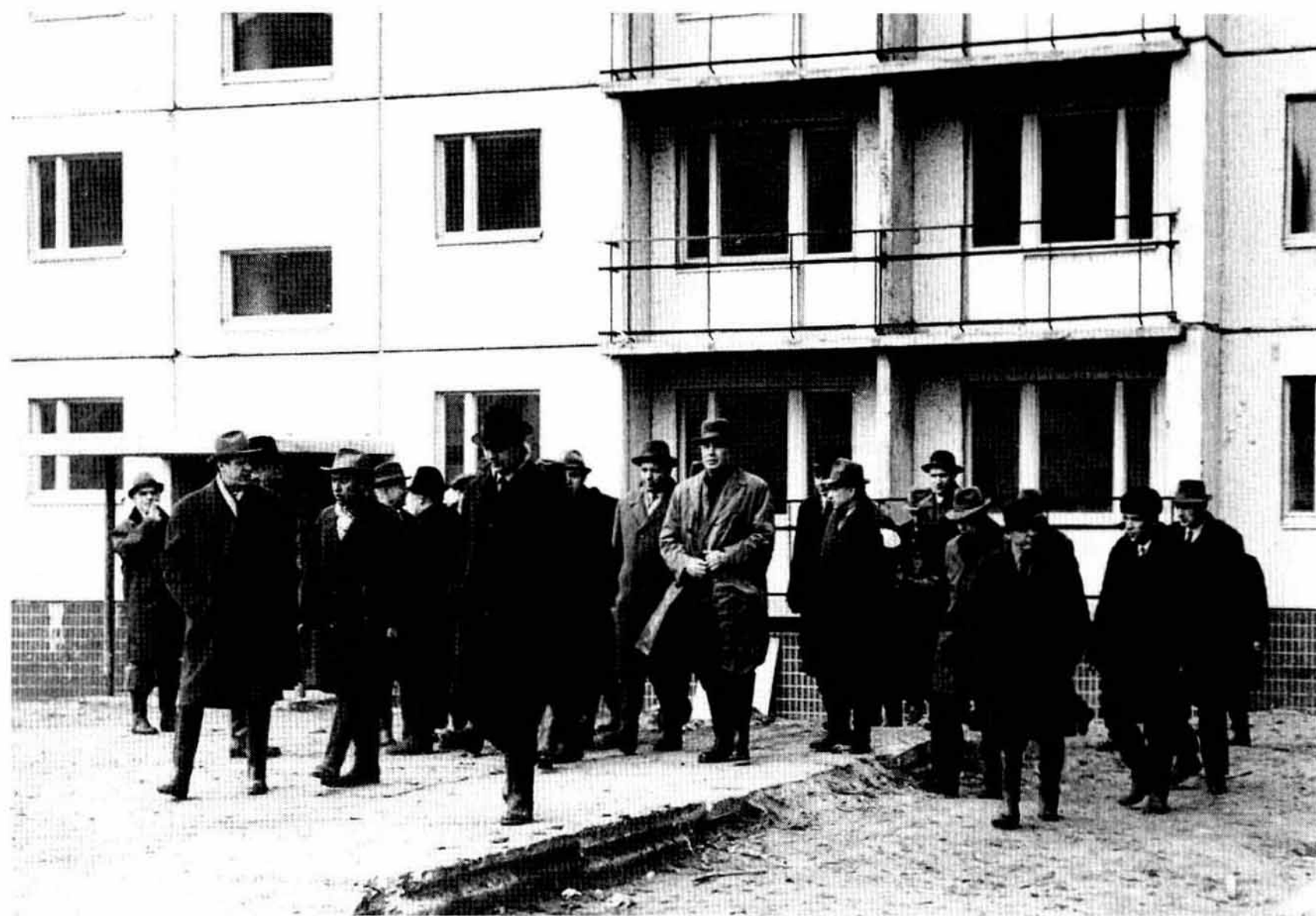
Осмотр строительства жилого района автозавода комиссией В. Н. Новикова. г. Тольятти, апрель 1969 г.
